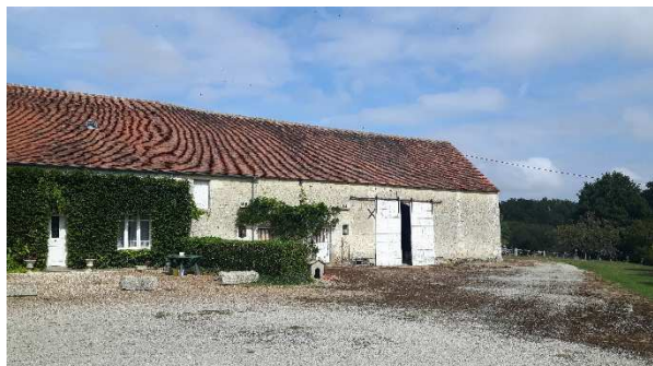
Ancienne ferme, avec logement
