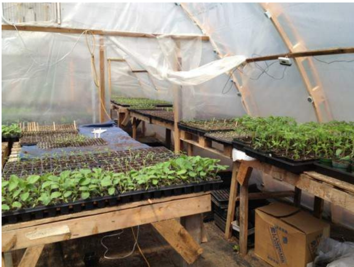
Illustration 15: Serre double paroi à armature bois, Amethys Farm
