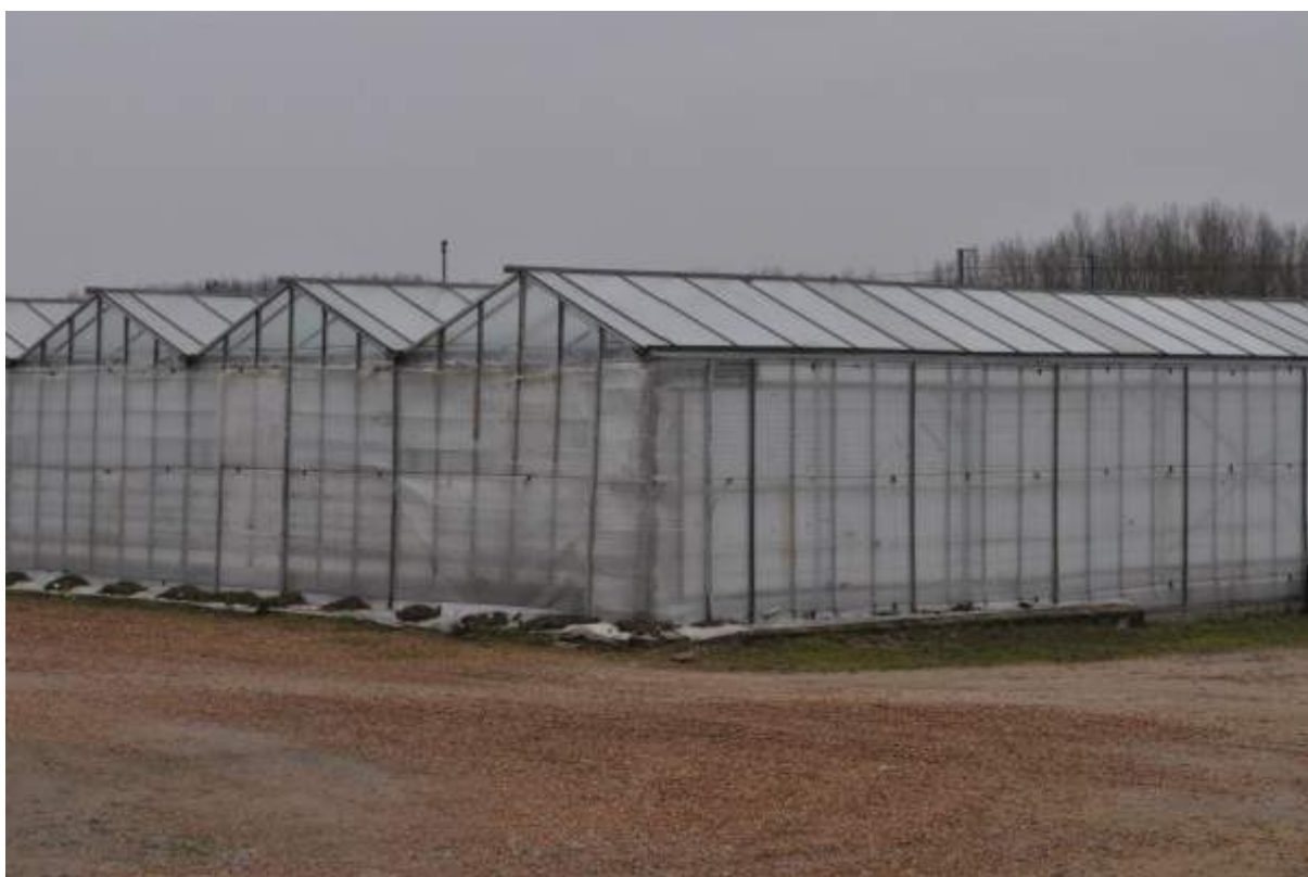
Illustration 20: Serres en verre chauffées enveloppées de papier bulle
