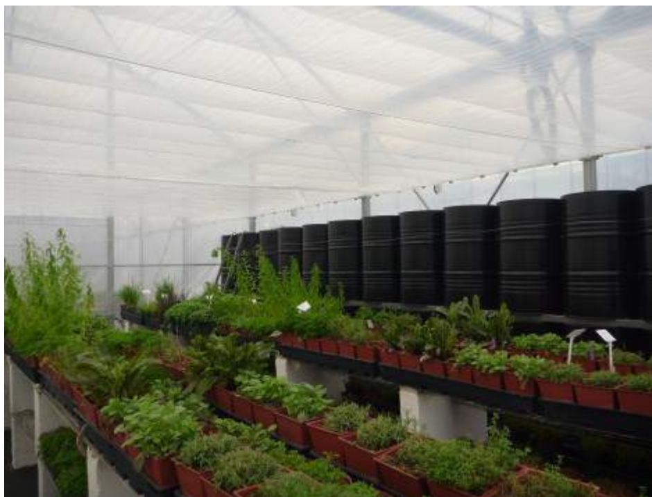
Illustration 11: Des barils métalliques noirs remplis d'eau ajoutent de l'inertie thermique à cette serre.
