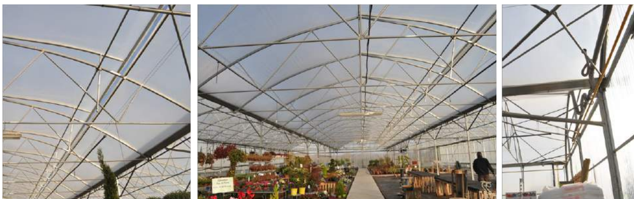
Illustration 9: Serre à toiture en double parois sous pression - ZI Boitardière Amboise
