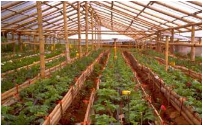
Illustration 5: Serre en bambou dans une ferme horticole écologique aux Philippines, Earth Flora Inc.
