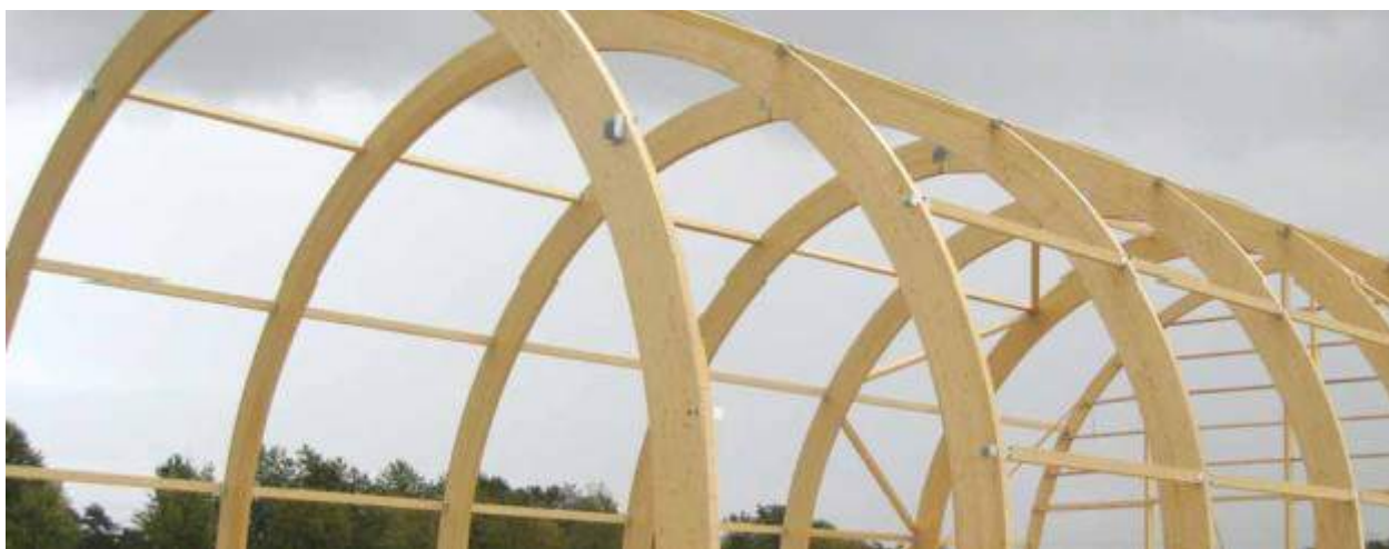
Illustration 18: La méthode du lamellé-collé permet de créer des structures courbes en bois
