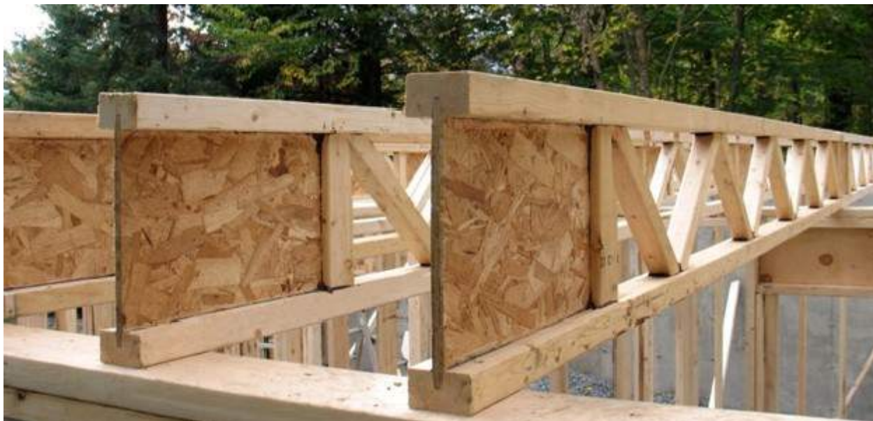
Illustration 17: Les structures de poutre treillis et de profilé en I fonctionnent aussi en bois
